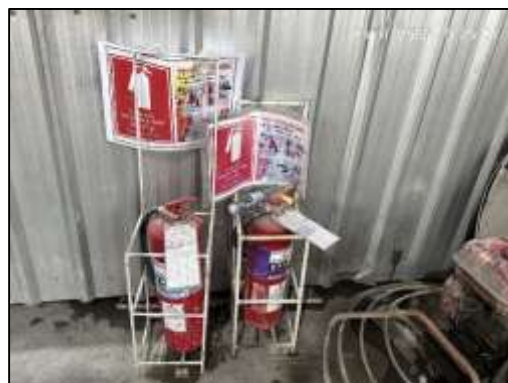
ภาพที่ 20 ถังดับเพลิง และป้ายแนะนำการใช้
